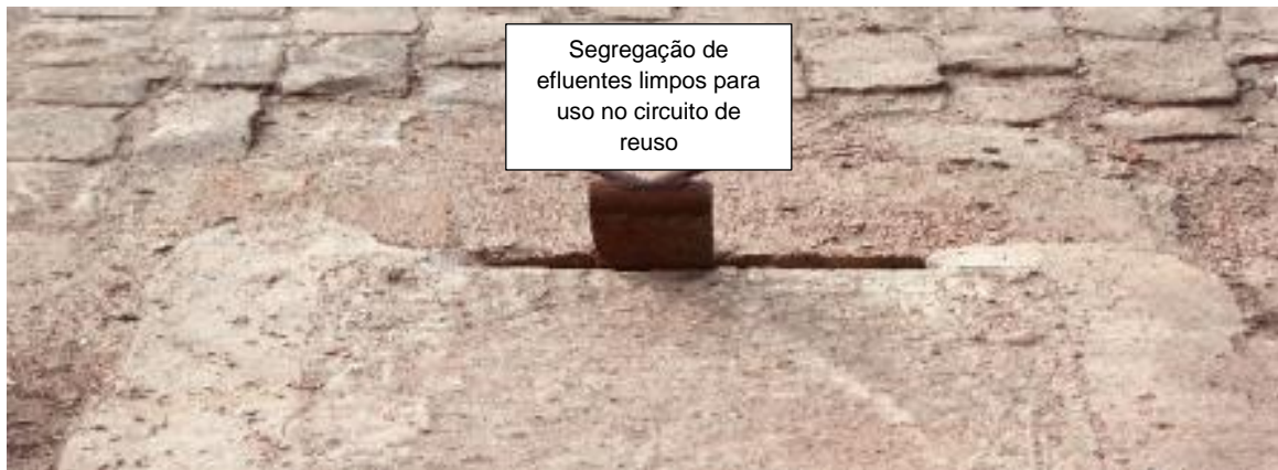
Foto 5. Comporta para segregação
