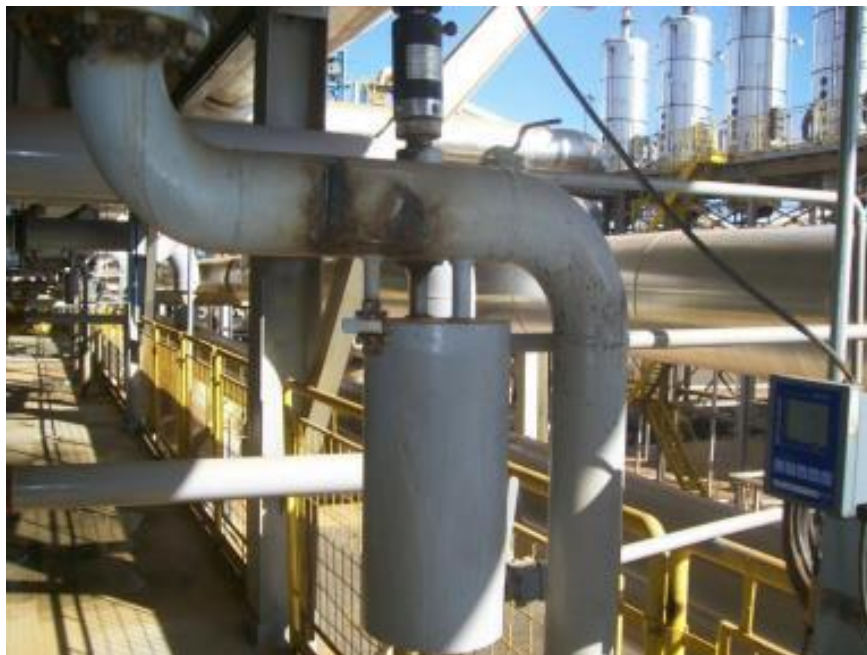
Foto 7. Condutivímetro instalado em linha para análise e alarme de contaminação e desvio
