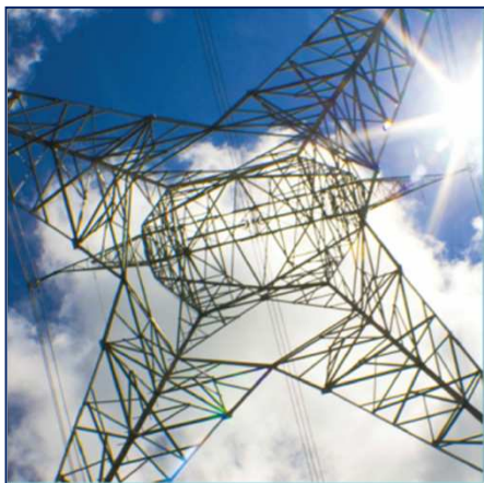
TRANSPORTE DE ENERGIA
